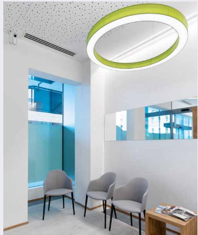
MRCT Diagnosezentrum, Dr. Andreas Oberhauser GmbH Innsbruck, EDMUND SPARER Klima & Kältetechnik GmbH
