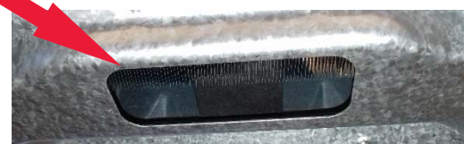
A KIVEZETŐCSONKOT IS FŰTI A KONDENZÁTORHŐ
